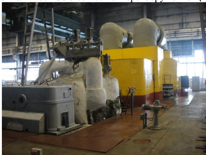
Рис. 8.1.8. ТЭЦ-4. Турбина Т-100-130 ст. № 7. Техпереворужение ЦВД
