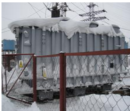
Рис. 8.1.4. Автотрансформатор
