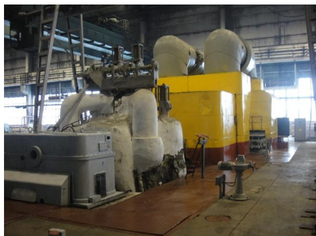
Рис. 8.1.5. Турбина Т-100-130 ст. № 7
